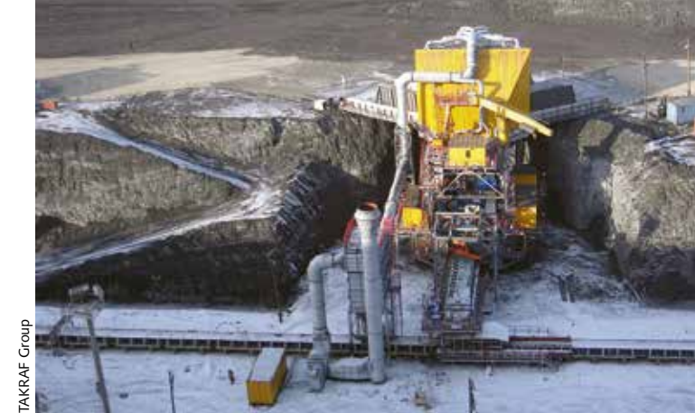
Eine von 2 x 4.250 t/h semi-mobilen Brechanlagen für Abraumbeseitigung in Kasachstan – IPCC-System • One of 2 x 4,250 t/h semi-mobile crushing plants for overburden in Kazakhstan – IPCC system
